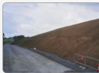
Cobertura recuperada, com a utilização do Fortrac® 3D.
