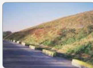
Cobertura vegetada e estabilizada após conclusão da obra de recuperação.
