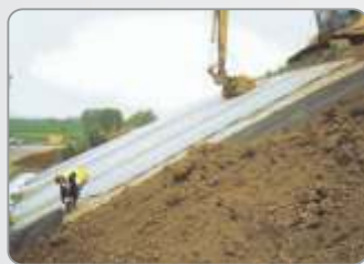
Recuperação da estrutura com instalação do Fortrac® 3D.
